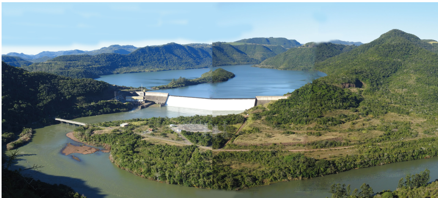
Fig 20- Vista panorâmica da barragem do rio Jacuí e vista do Geossítio Mirante da barragem de Dona Francisca, no município de Nova Palma
